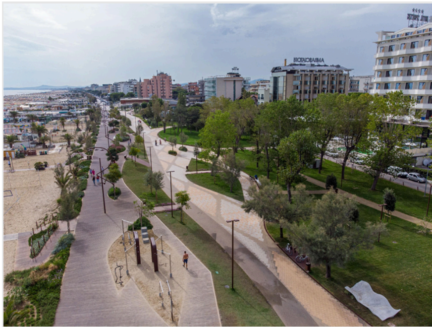
Figure 34 - Overhead view of Parco del mare (Lungomare Tintori).
