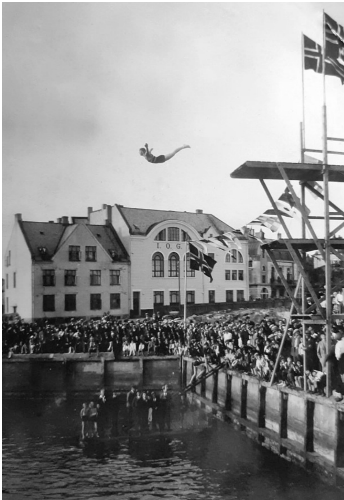
Stupetårn og tilskuere ved Storneskaia Foto: Sunnmørsposten/smp.no
