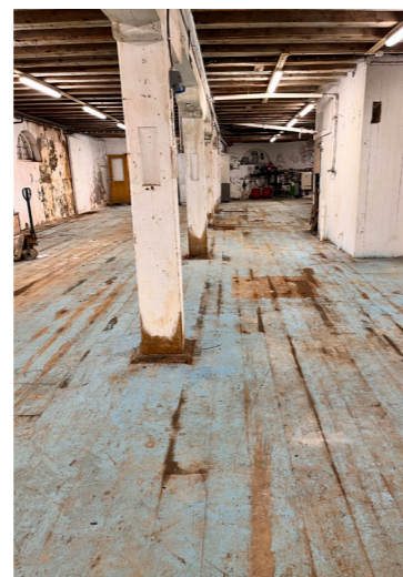
Plan U med antatt opprinnelig tregulv mer eller mindre rett på grunn. Kan muligens ombrukes.
