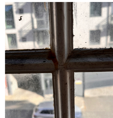
Originalt vindu, med smale profilerte sprosser
