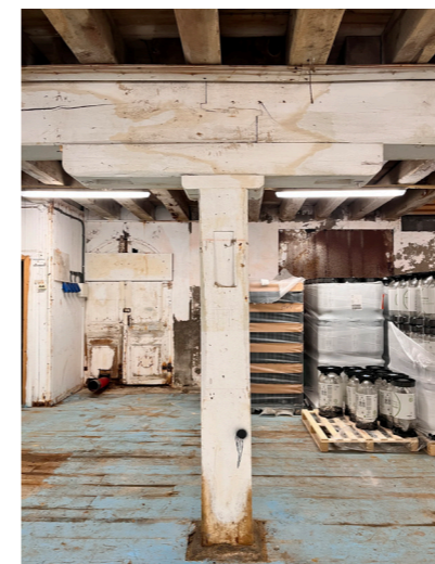
Robust konstruksjon, modifisert hvor skråavstivere er fjernet. Gjelder stort sett alle stolper.
