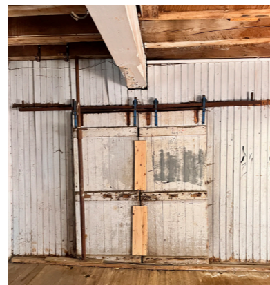
Skyveport med utenliggende hengsling Tregulv fra byggeår
