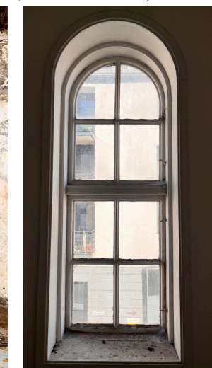
Originalt vindu med inntakt belstning og foringer østfasaden
