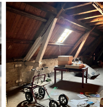
Takvindu på loft, antatt opprinnelig og kan benyttes som modell for replika
