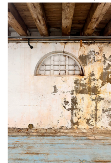
Buet utsparing og vindu mot gate i plan U - originalt
