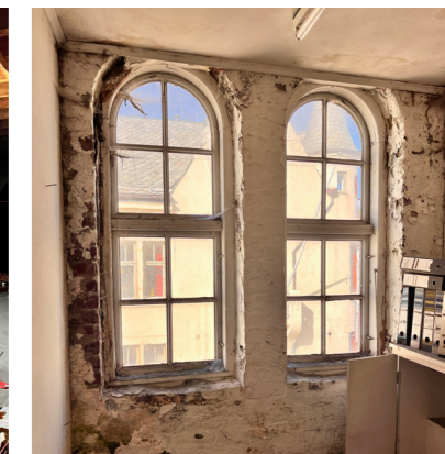
Originale vindu på nordfasaden, kan benyttes som modell for replika til vinduer i 3. etasje
